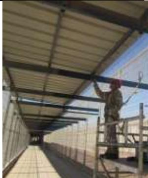
Figura 2. Actividad de pintura de estructura en rejas y cubiertas de pasillo.
