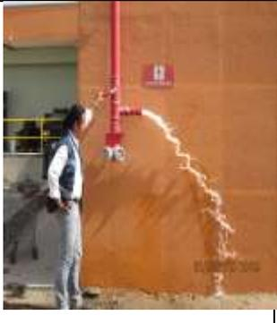
Figura 1. Se realizan pruebas y mantención a la red húmeda y Red Seca.
